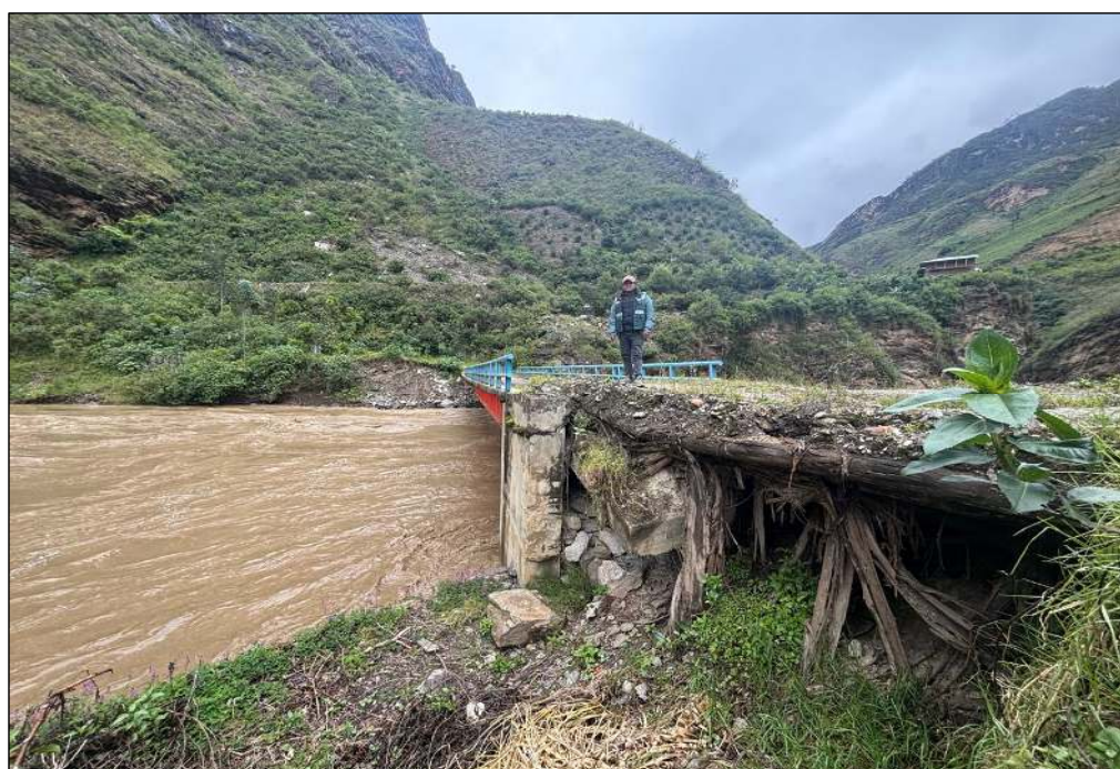
Figura N° 01. El puente sobre el río Marañón muestra un grave deterioro, con una sección colapsada que deja expuesta su base erosionada. La estructura de soporte, compuesta por troncos y raíces, está debilitada y parcialmente desprendida, lo que compromete su estabilidad.
